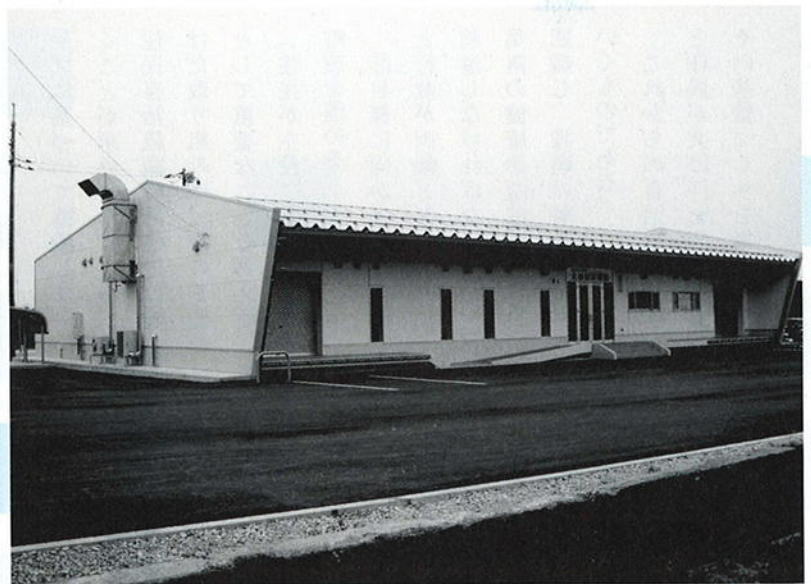
本稼動を待つ農産物処理加工施設
