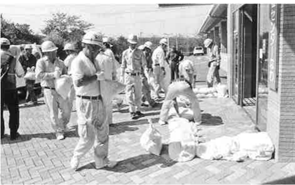
▶大山町建設業協議会による土嚢設置の様子
