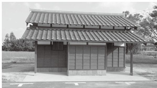
▲所子伝建地区の景観にあわせたトイレを設置
