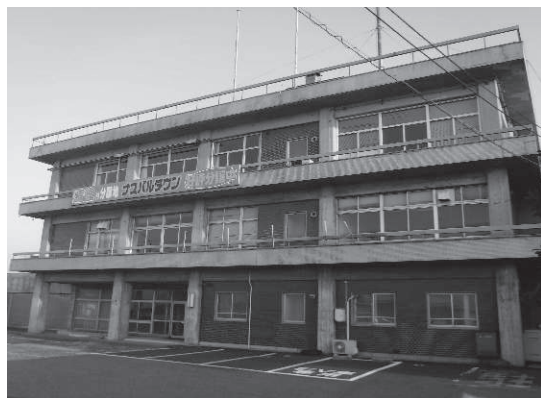
▲中山支所旧館
