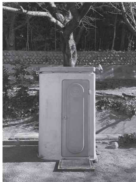
撤去予定の御来屋遊園地のトイレ
