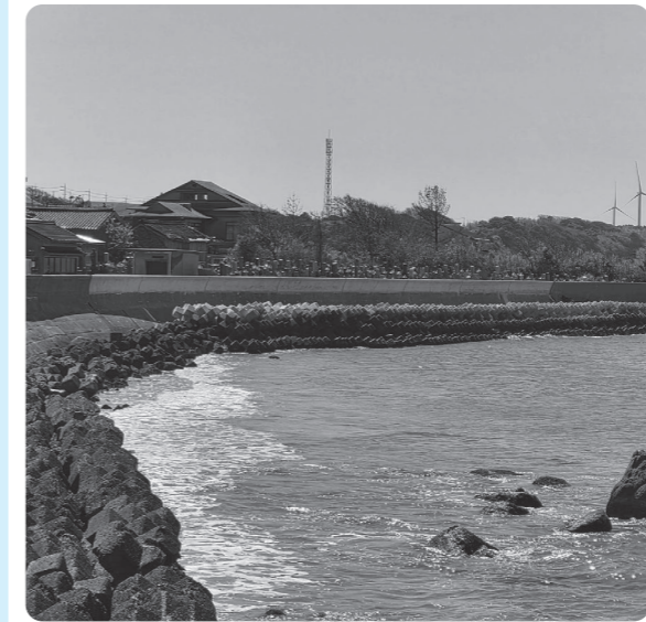
令和7年度に完了した護岸工事
