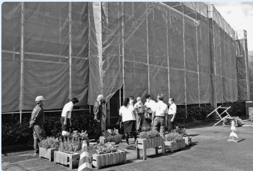
改修中の校舎を視察
