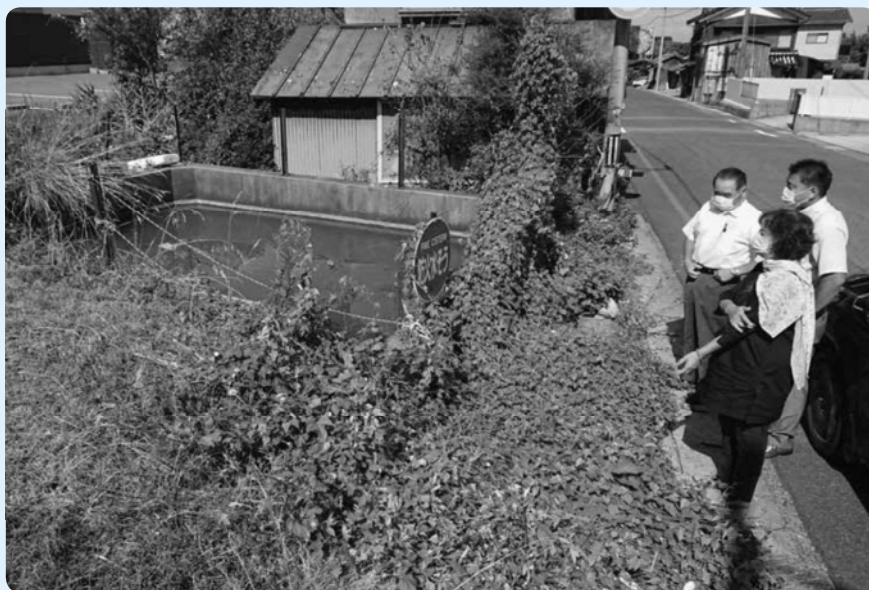
町負担で撤去する防火水槽
