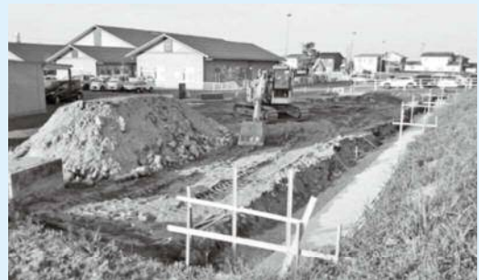
工事が始まる小規模保育所
