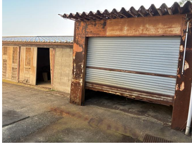
建物の奥の倉庫
