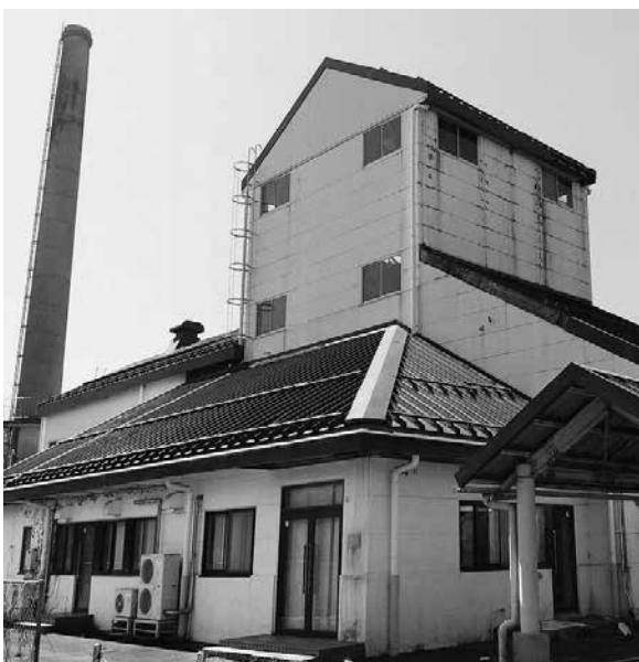
解体される中山清掃センター
