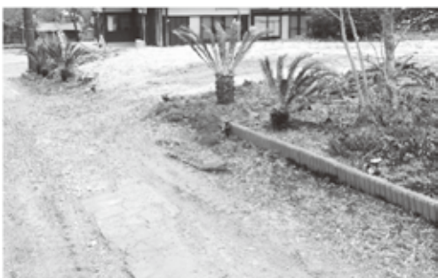
↑崩れかけていた居宅とつる草に覆われていた倉庫を解体した跡
