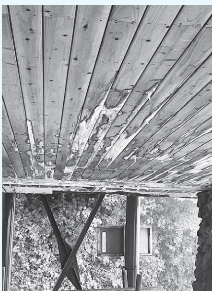
ロッジだいせん入口天井の修繕
