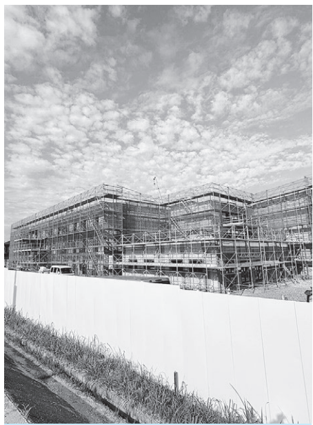
建設が進む定住促進子育て住宅
