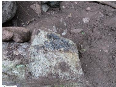
写真15 解体築石の被熱痕
