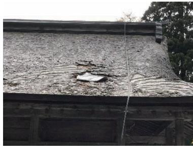
写真 84 柿葺破損部応急処置（長廊）
