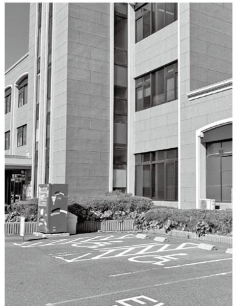
上屋がなくて良いのか
